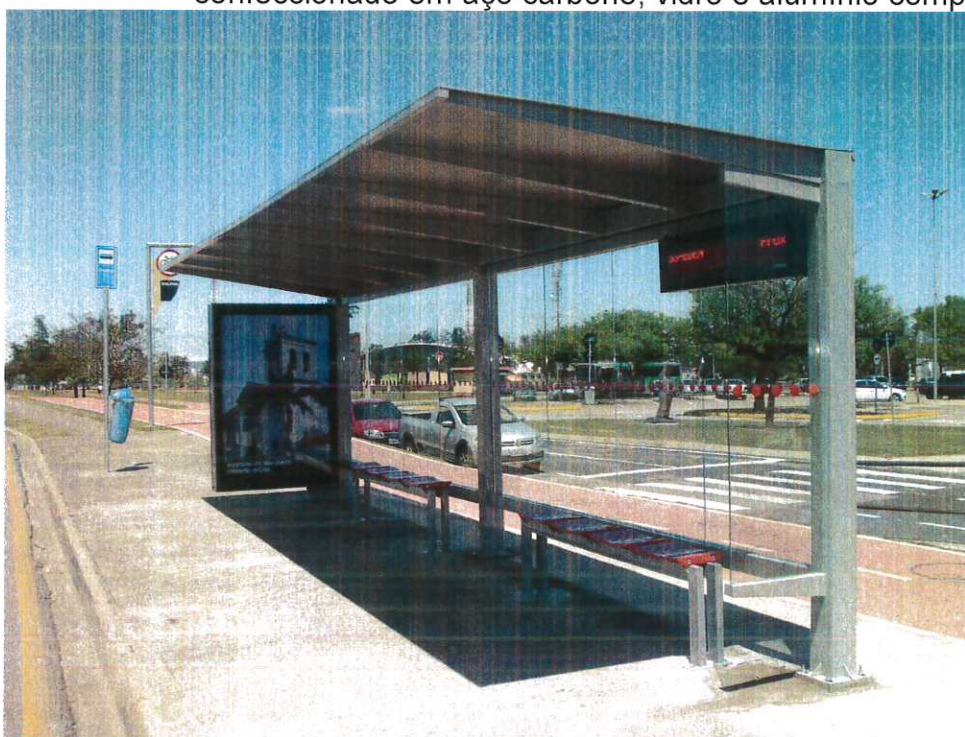
Foto: Abrigo de Vidro com MUPI – frente ao PAÇO
